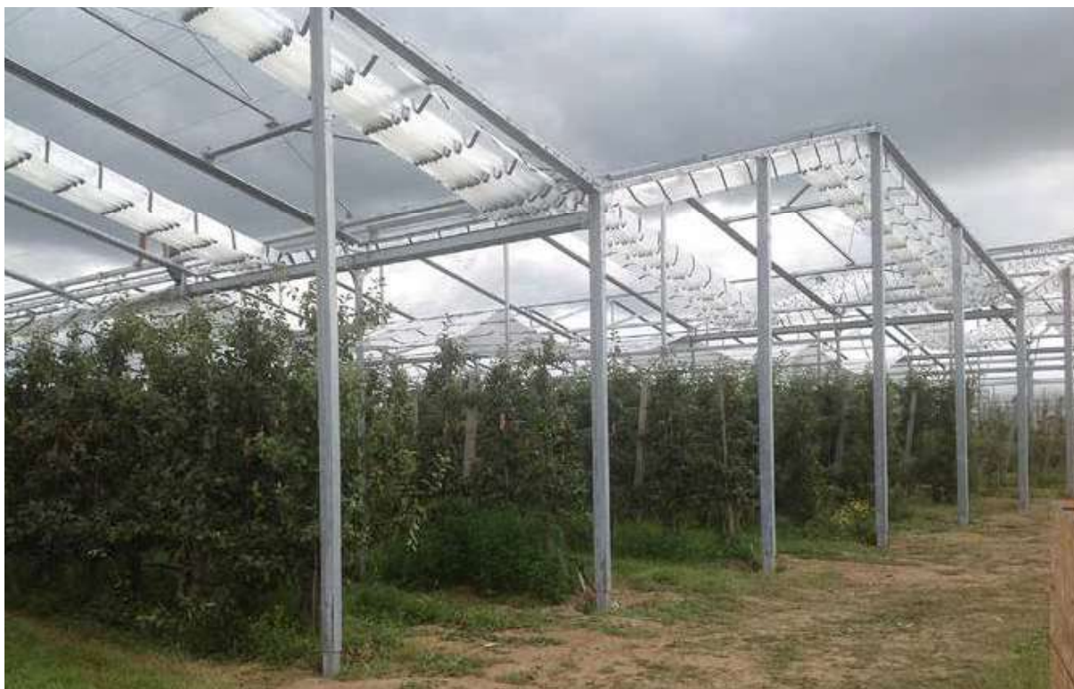
Cabrio-kap: bij regen sluit het dak boven de appelbomen (foto: WUR).
