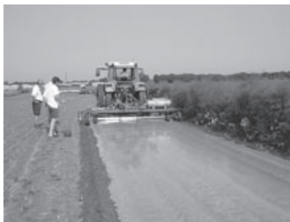
Machinaal leggen van het folie.
